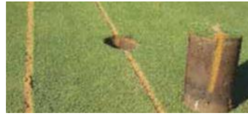
A barázda 15-22,5 cm mélységig kerül feltöltésre homokkal.
